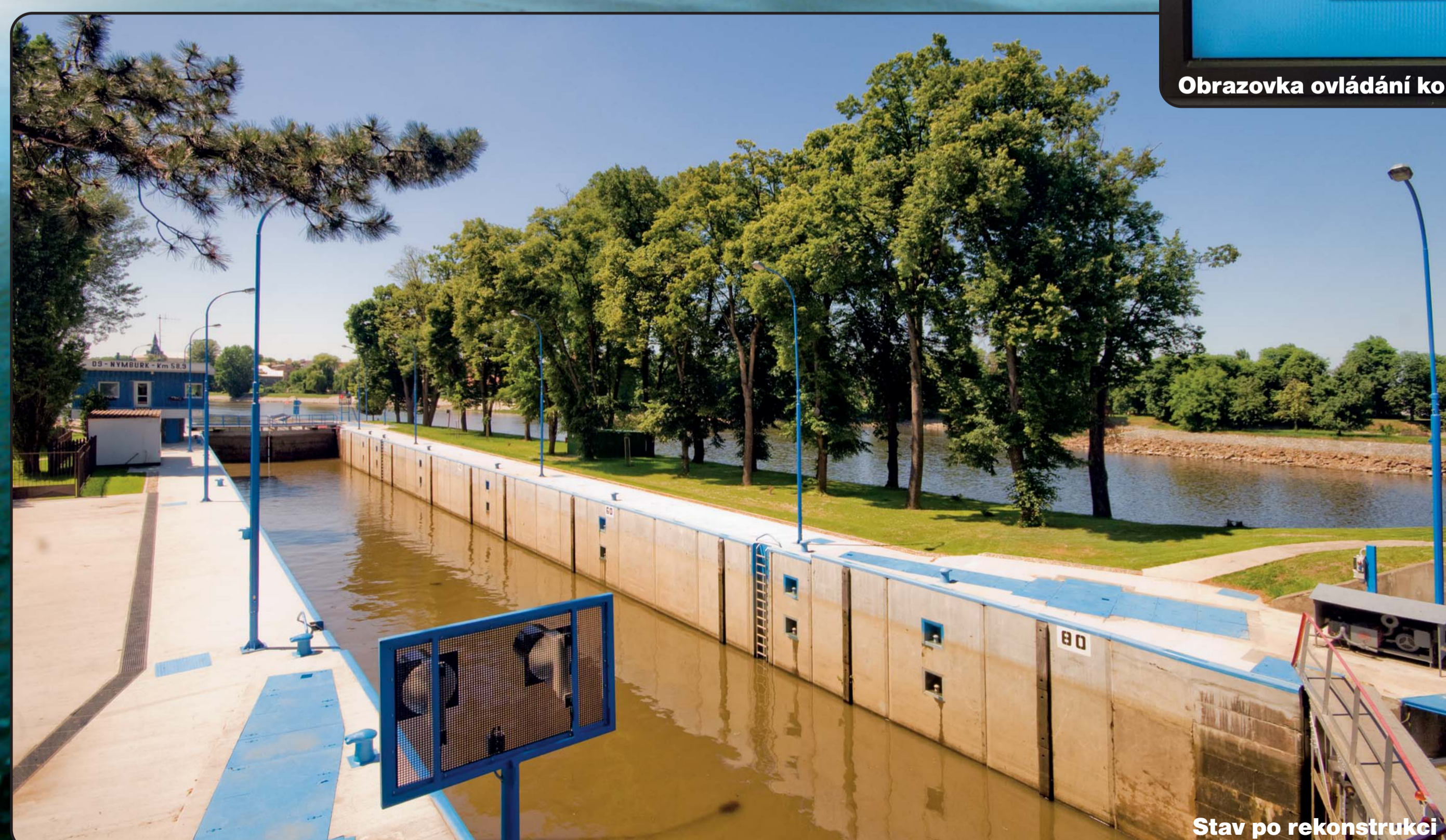
Stav po rekonstrukci
