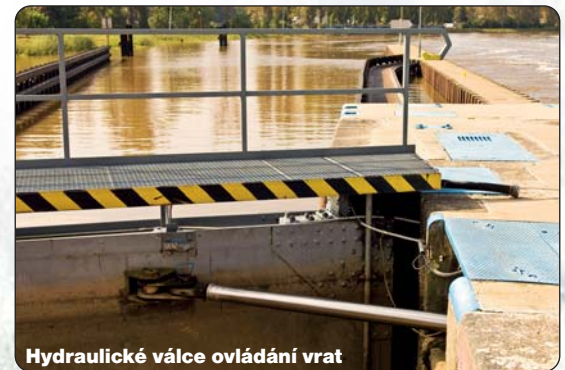
Hydraulické válce ovládním vrat
