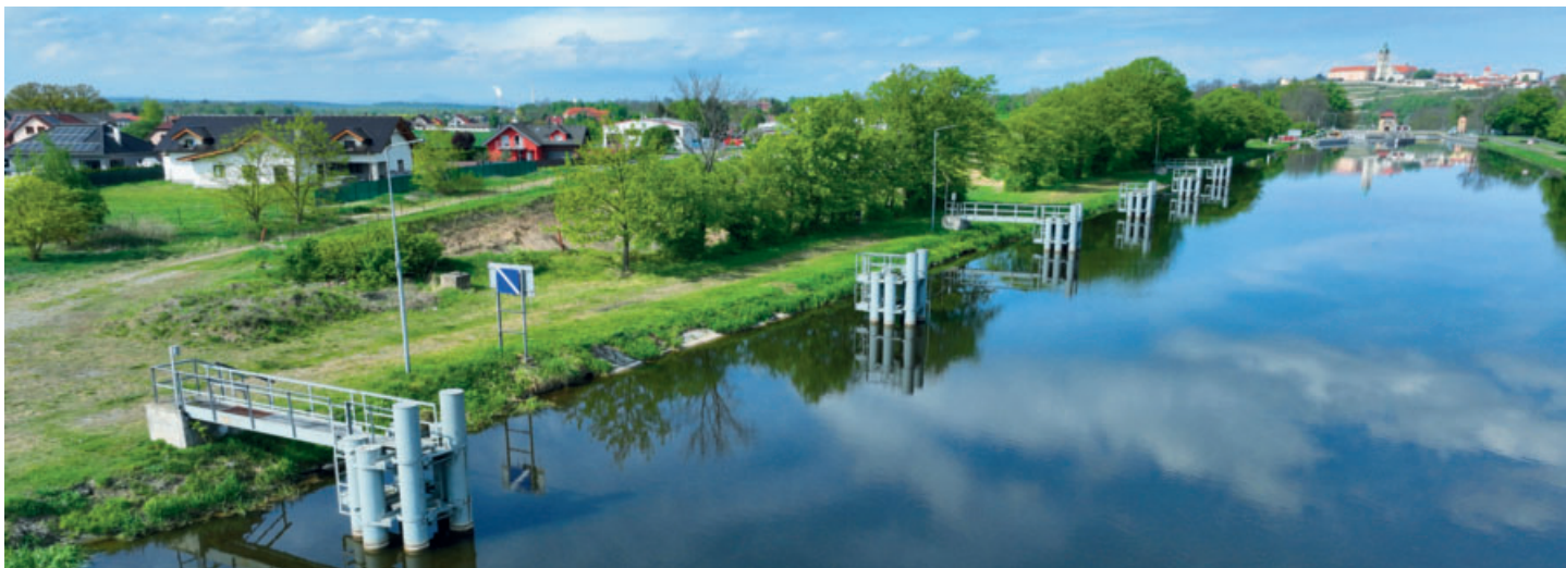
Stavba nových čekacích stání pro malá plavidla u plavební komory Hořín (horní rejda, před vypuštěním kanálu)
