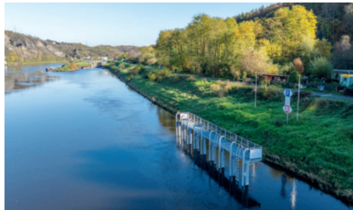
Nová čekací stání pro malá rekreační plavidla u plavební komory v Roztokách u Prahy – dolní rejda
