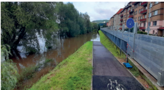
Stavba mobilního PPO hrazení na pravém břehu Labe v Ústí nad Labem
