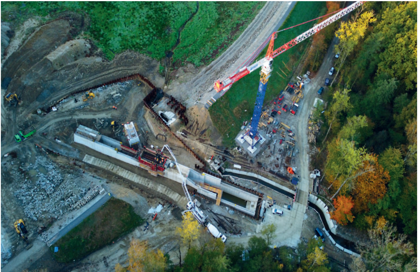
Betonáž stropu odpadní štoly 25.10.2024, archiv stavby
