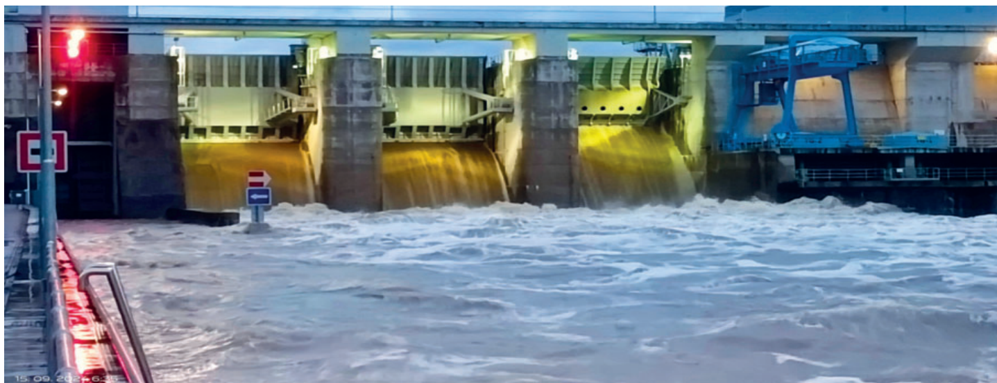
Vodní dílo Hněvkovice poprvé naplno využilo upravené bezpečnostní přelivy pro převádění velkých vod
