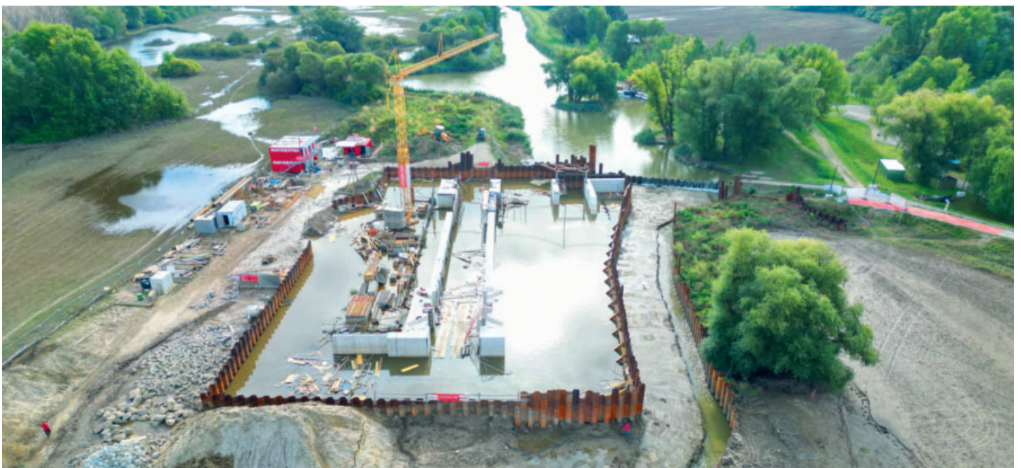
Staveniště plavební komory Rohatec/Sudoměřice po opadnutí vody
