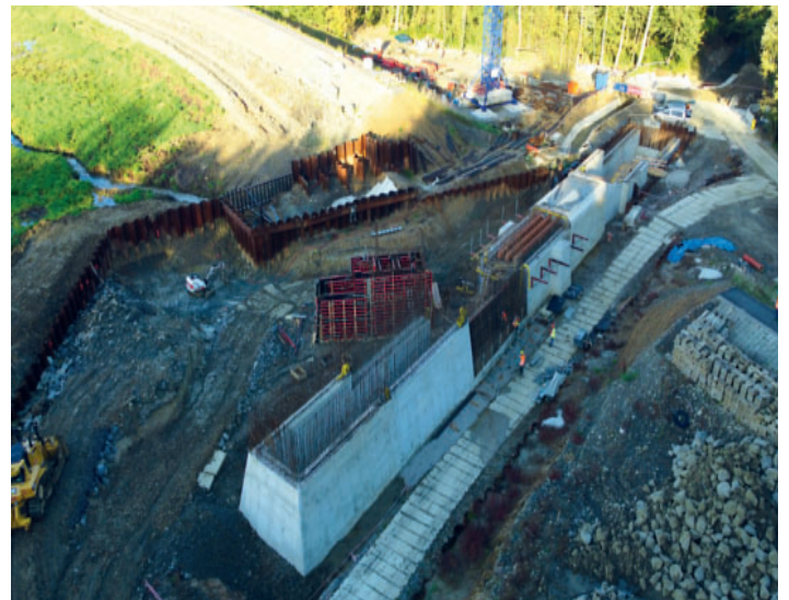
Pohled na rozpracovaný sdružený objekt 8.10.2024, archiv stavby
