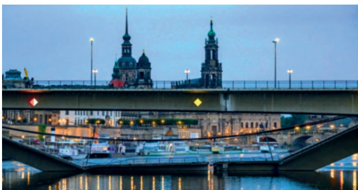
Zřícený most Carolabrücke v Drážďanech 11. září 2024
