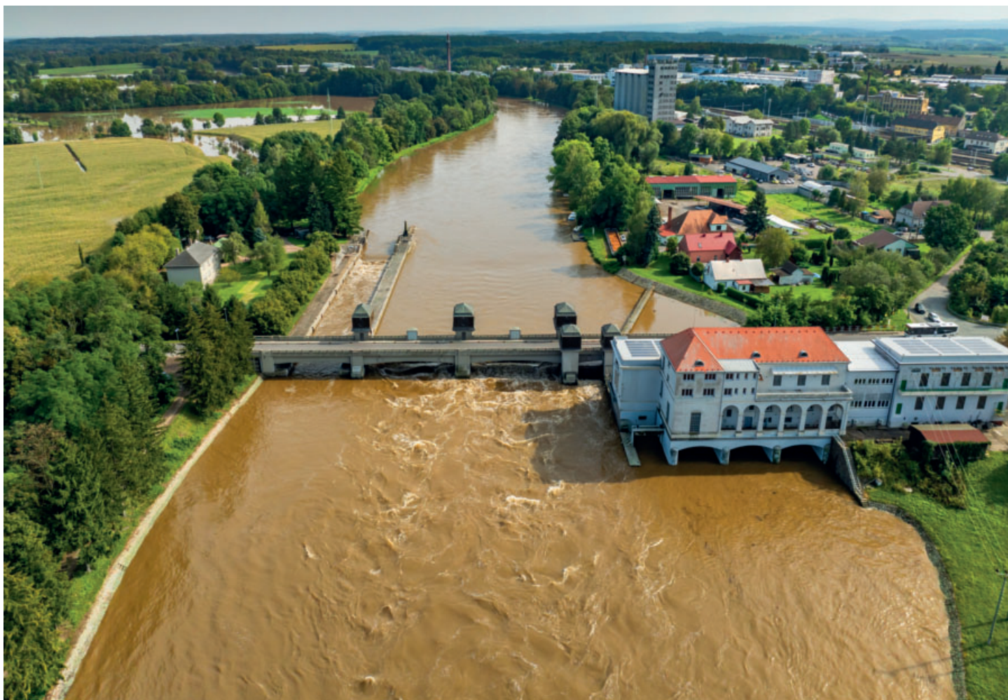
VD Přebouč v průběhu povodně
