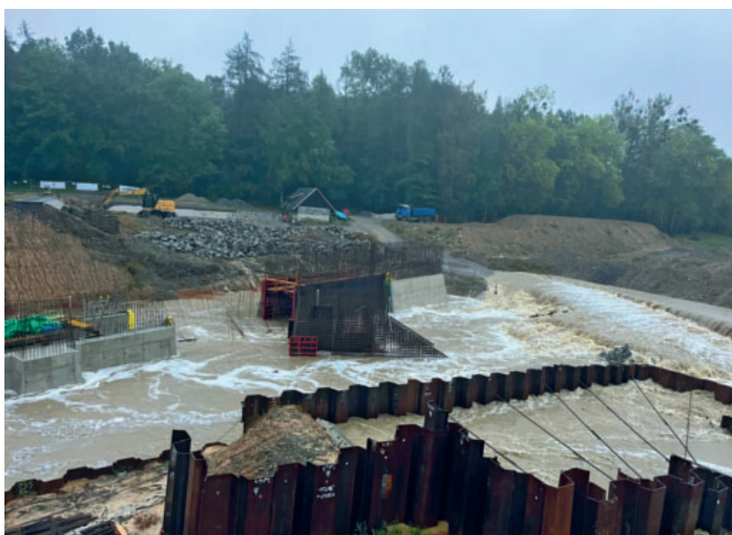
Kulminace hladiny v nádrži 15.9.2024, archiv stavby
