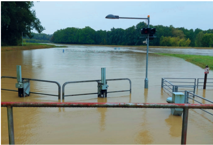
Zaplavená dolní rejska plavební komory Nedakonice
