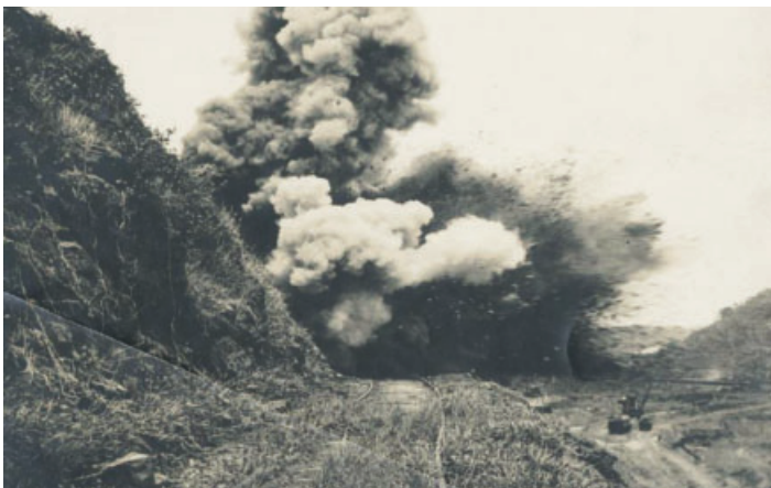
Při stavbě Panamského průplavu bylo použito ohromujících 27 milionů kilogramů dynamitu
