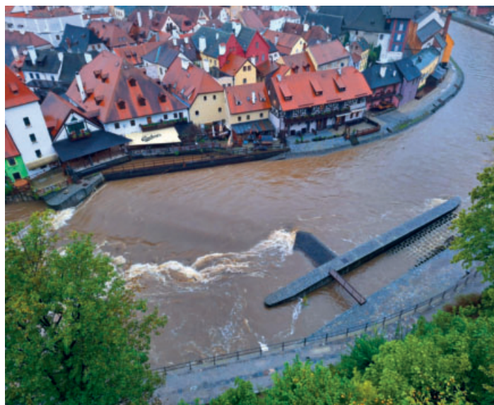
Zmodernizovaný jez v Českém Krumlově umožnil významně snížit hladinu řeky Vltavy v centru města
