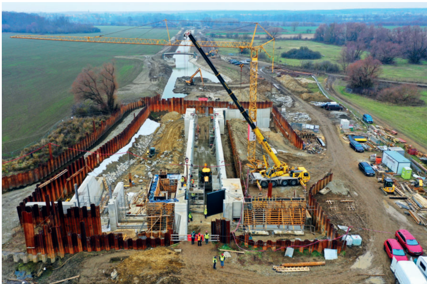
Staveniště plavební komory Rohatec/Sudoměřice na Baťově kanále
