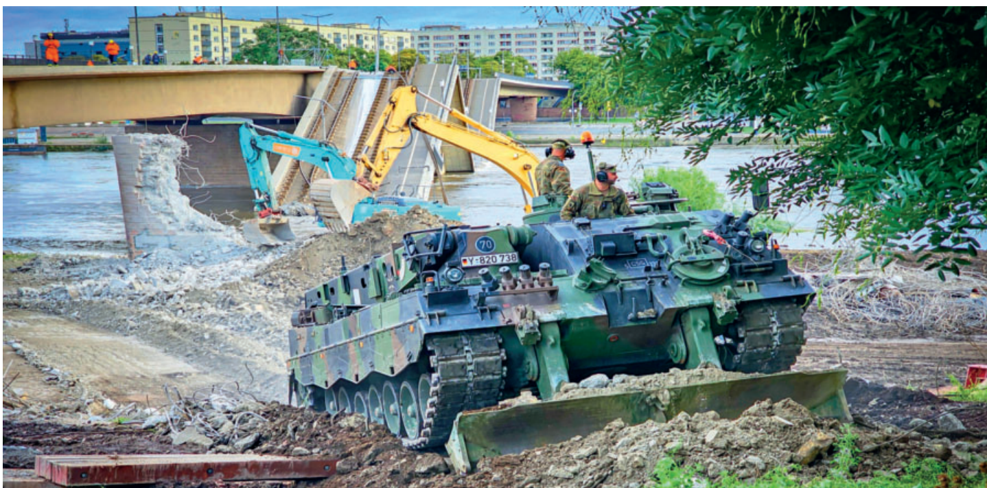
Intenzivní demoliční práce zřícené části mostu Carolabrücke za použití těžké civilní a vojenské techniky 13. září 2024
