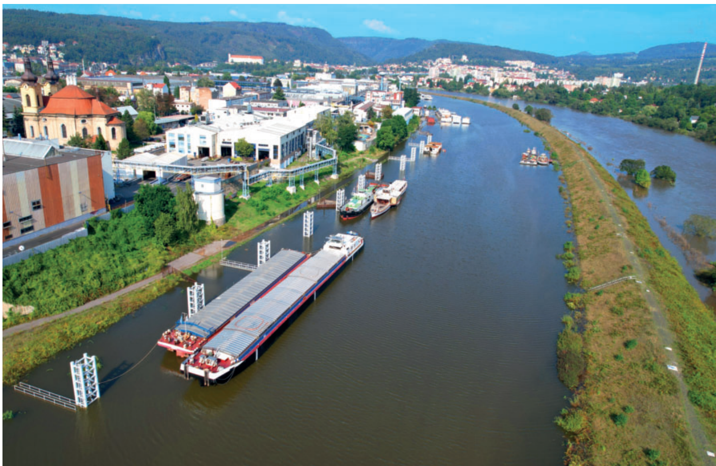
Ochranný přístav Děčín-Rozbělesy během povodně dne 19. září 2024
