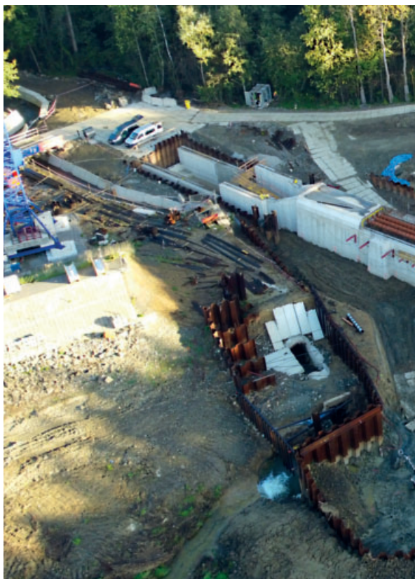
Pohled na hotové bednění nátokového objektu spodních výpustí 8.10.2024, archiv stavby
