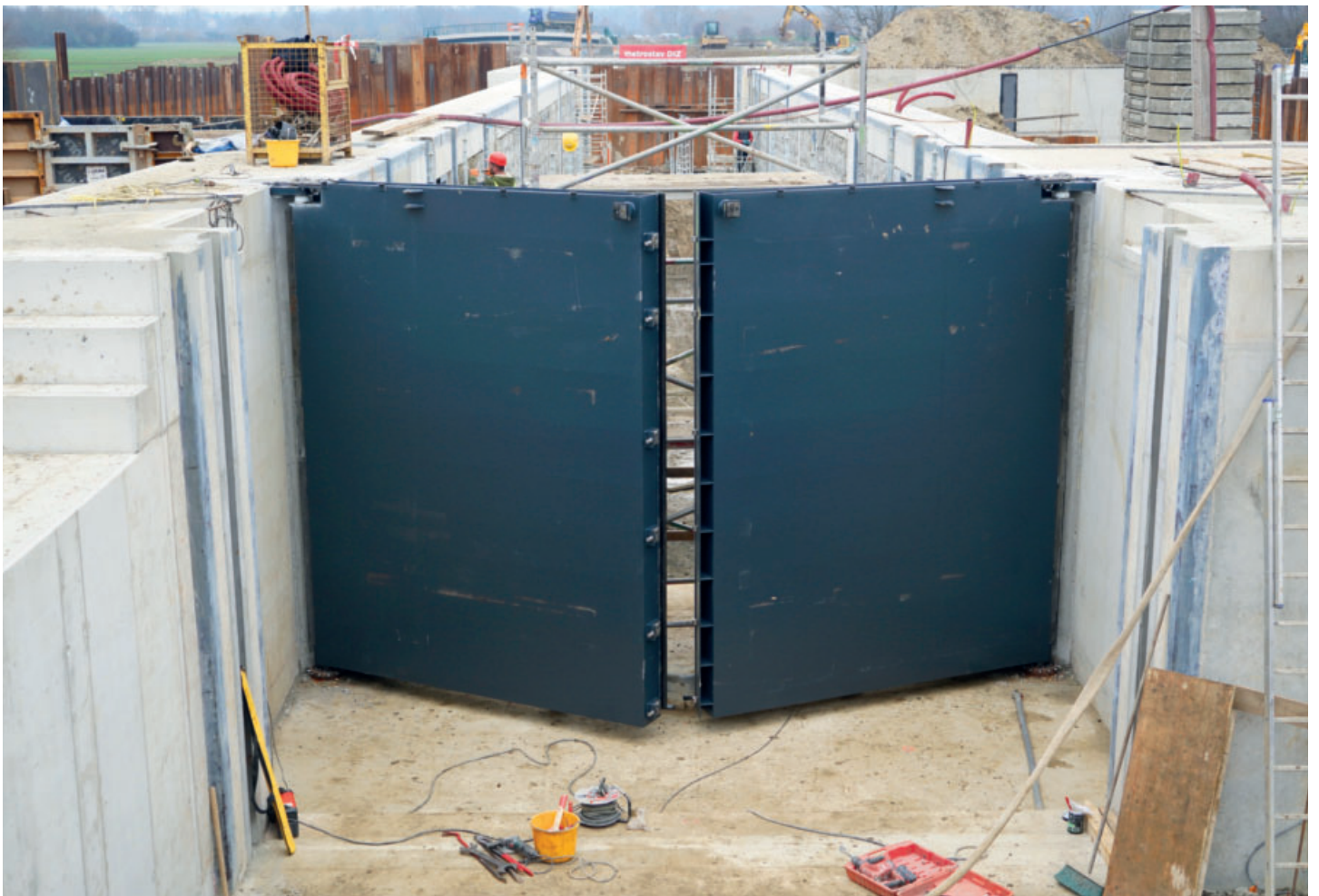
Osazování horních vrat plavební komory Rohatec/Sudoměřice
