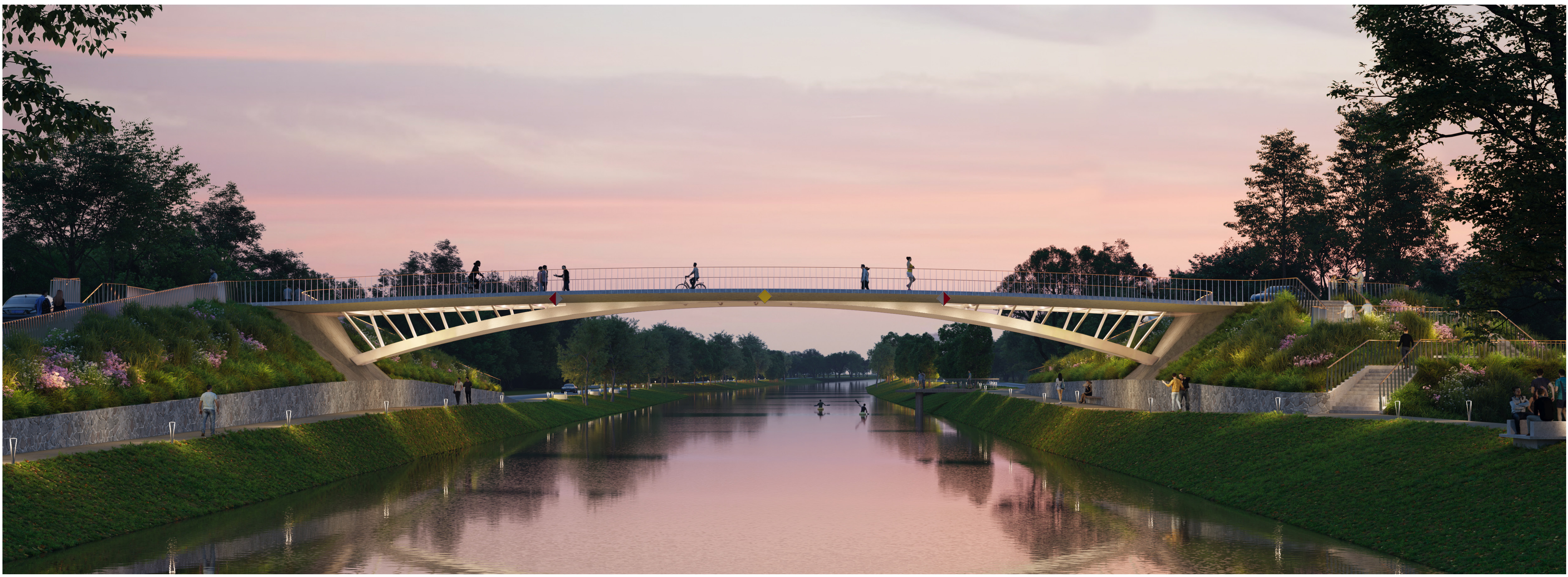
Přemostění z úrovně plavidla na plavebním kanálu v záběru proti vodnímu proudu
