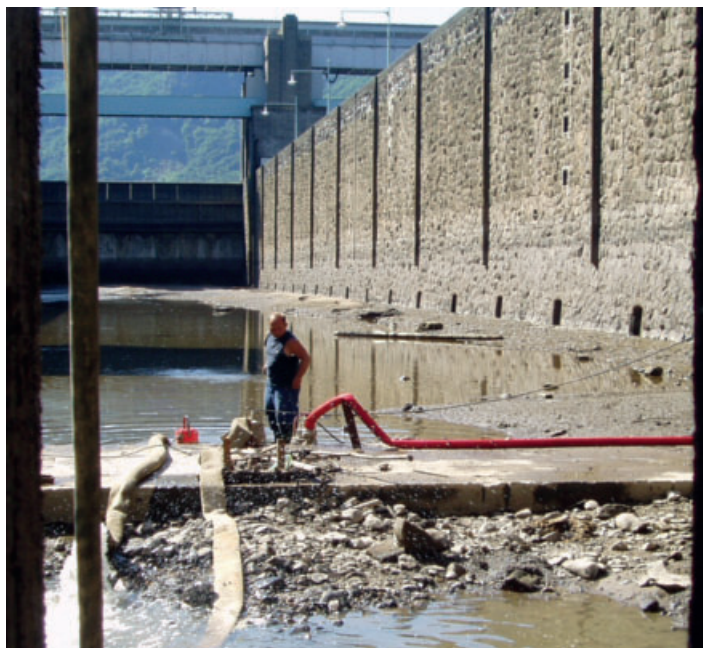
Vyčerpaná velká plavební komora
