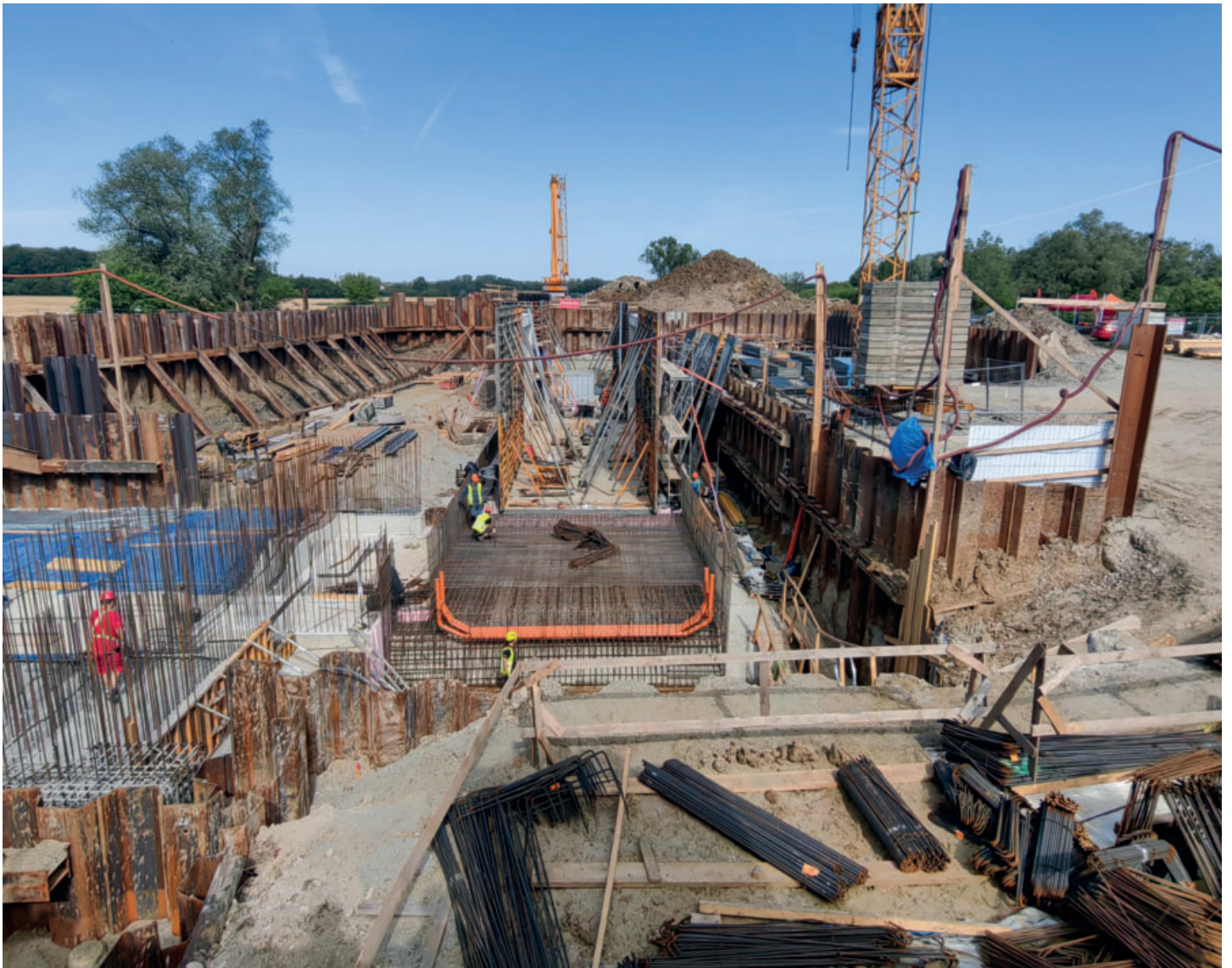
Stavba plavební komory Rohatec/Sudoměřice - stav 1. května 2024
