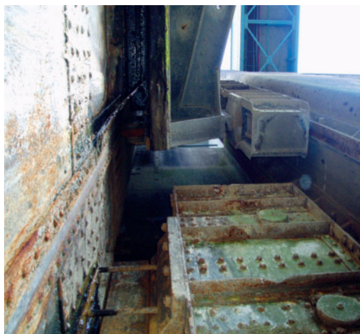
Horní vrata před rekonstrukcí
