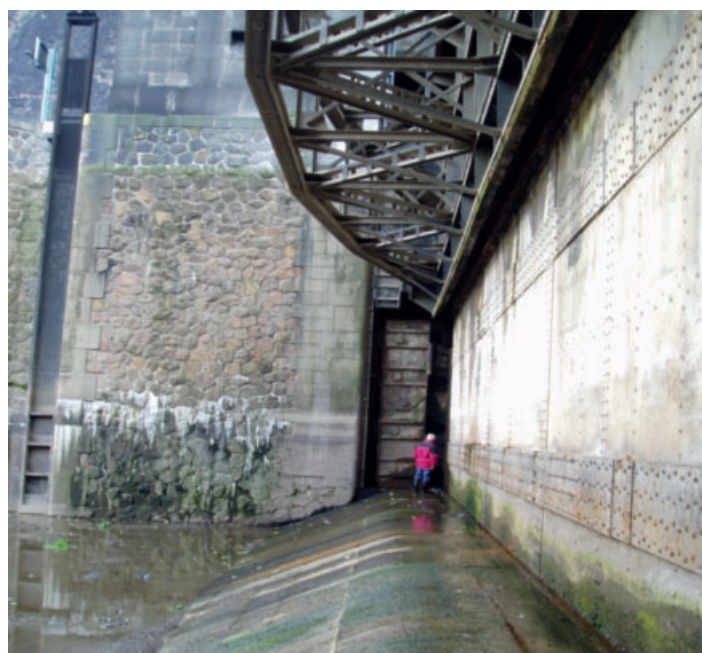
Horní vrata velké plavební komora
