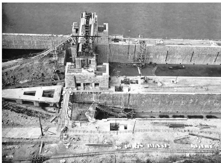
Stavba horního ohlaví
