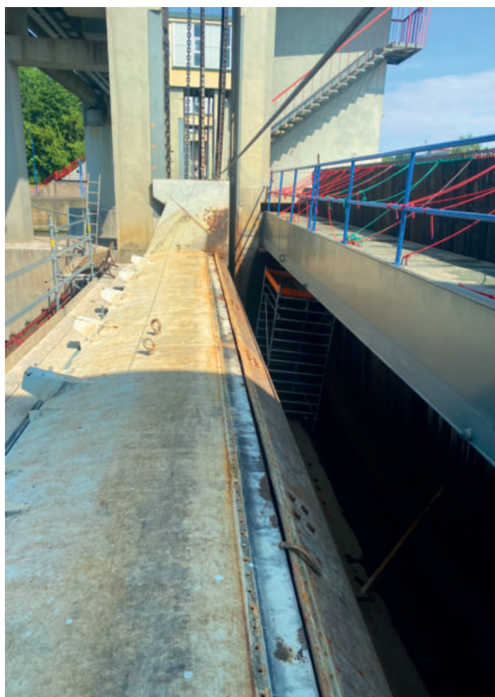
Těleso klapky po demontáži těsnění
