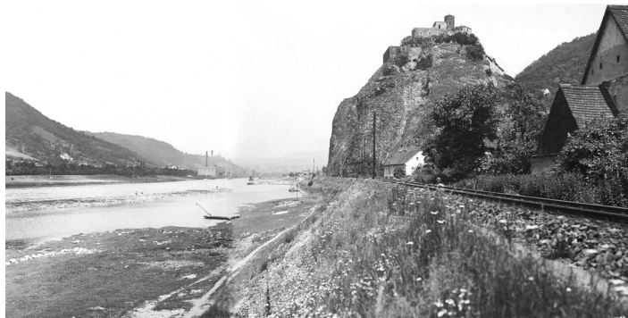
Zahájení stavby plavebních komor
