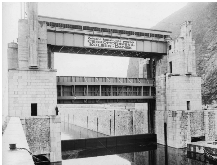
Dokončené horní ohlaví velké plavební komory
