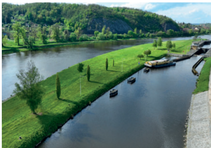
Horní rejdá plavební komory Dolánky
