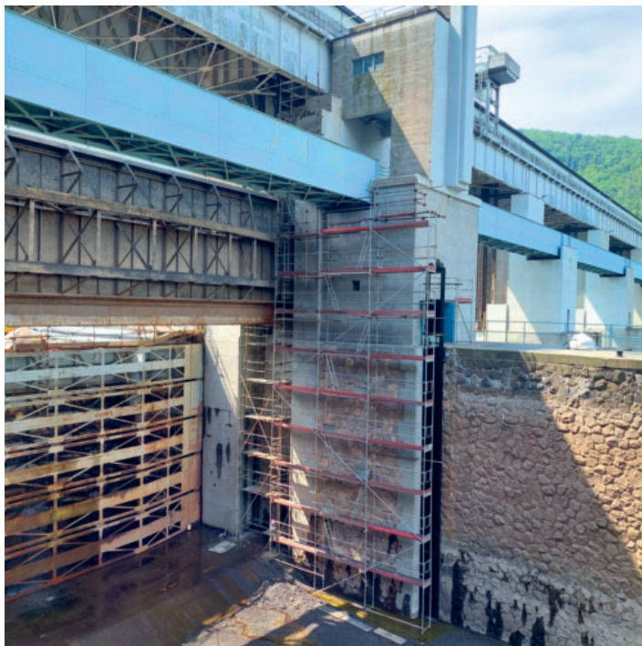
Oprava horního ohlavi
