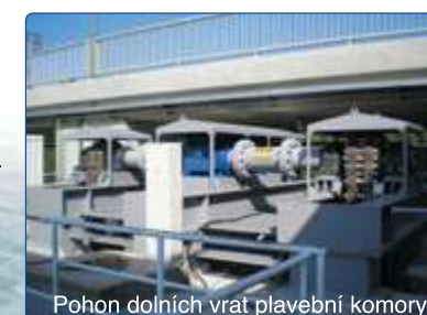
Pohon dolních vrat plavební komory
