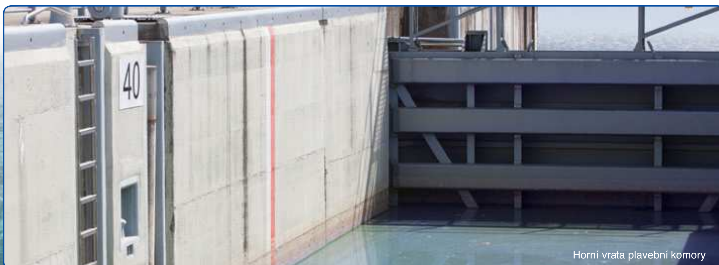
Horní ohlaví plavební komory
