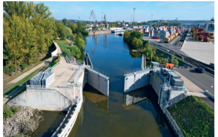
Otevírání protipovodňových vrat přístavu Mělník po poklesu hladiny Labe 23. 9. 2024
