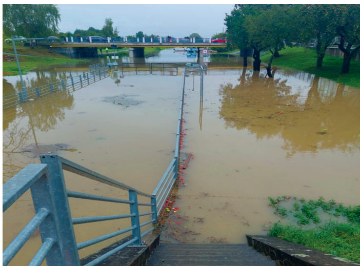
Zatopená plavební komora Staré Město
