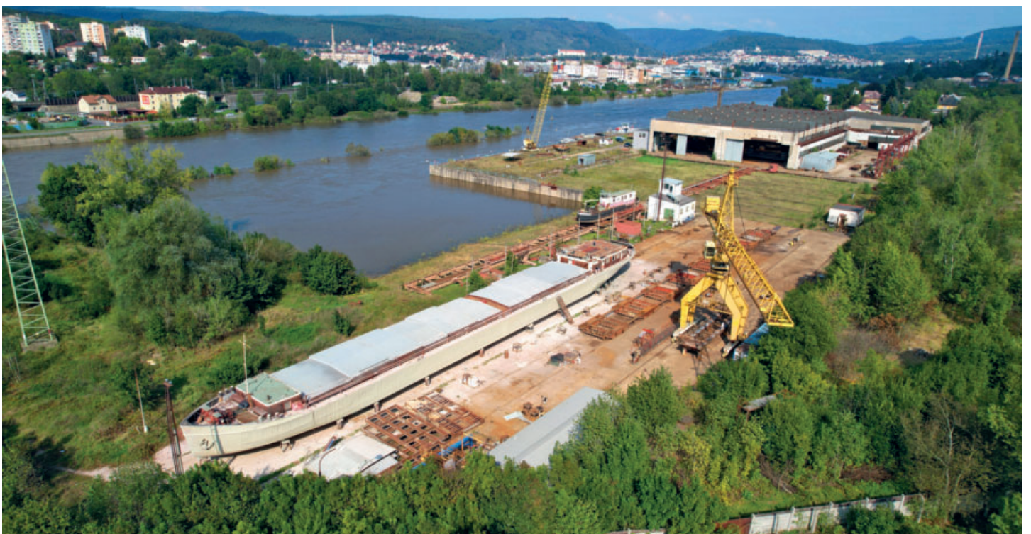
Areál Českých loděnic v Děčíně-Křešicích 19. 9. 2024
