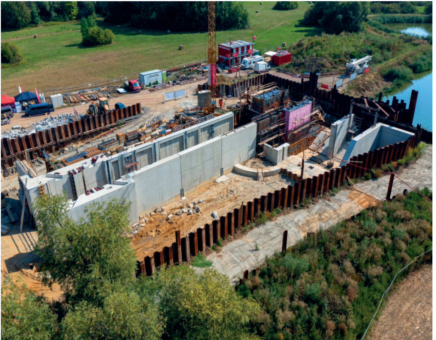
Betonáže plavební komory a jezu ve své závěrečné fázi
