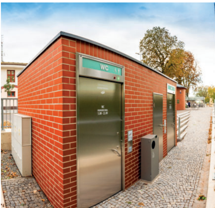
Svitavy – Nedaleko nádraží byla instalována modulová toaleta CWC 210 B, která zvýšila kvalitu života jak pro cestující vlakem, tak i pro místní obyvatele
