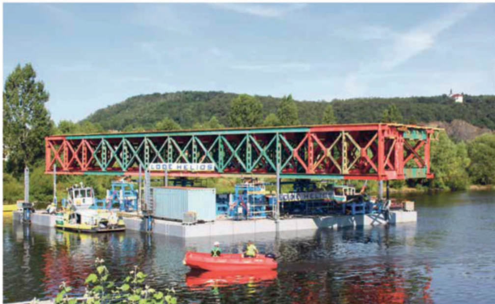
Ocelová konstrukce o váze 150 tun na pontonové lodi v Modřanech.
