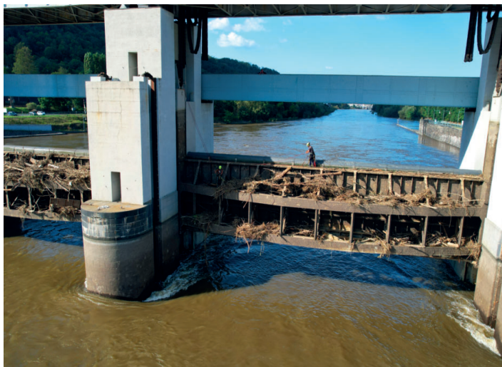
Pracovníci Povodí Labe čistí jezové pole na VD Střekov 20. 9. 2024
