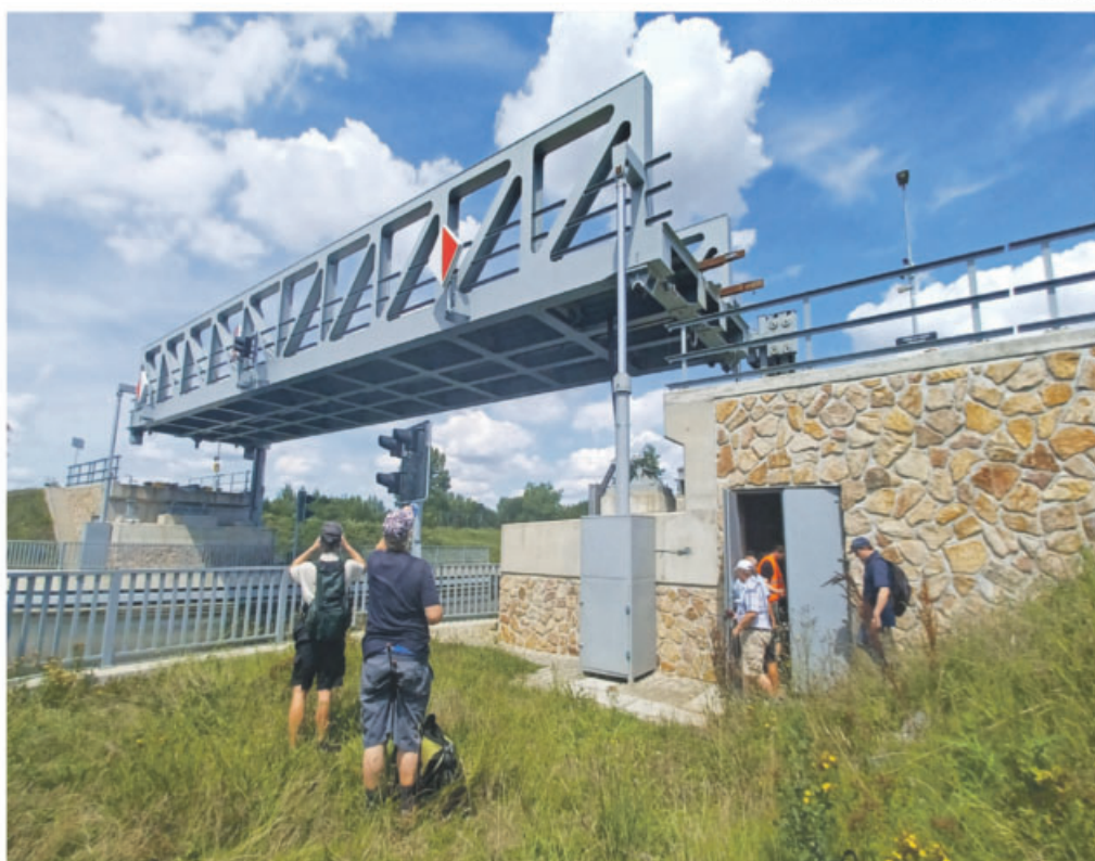
Most v Lužci nad Vltavou se zvedá o tři metry do výšky.
