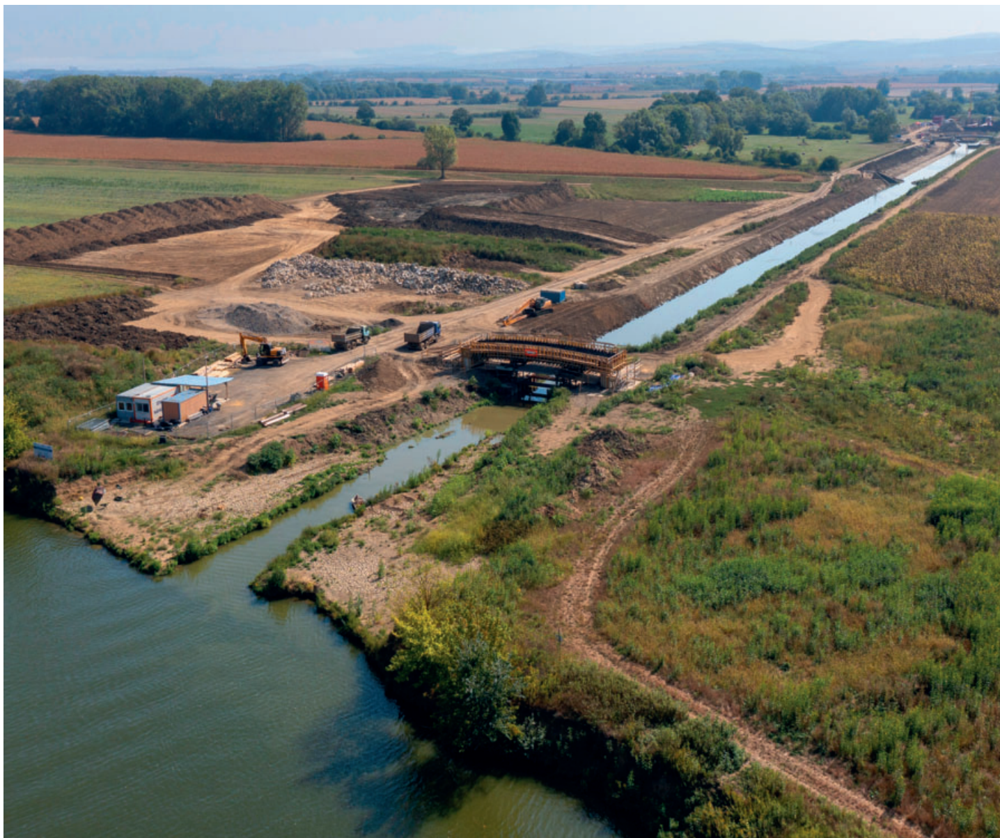
Práce na rozšiřování říčky Radějovky a stavba nového mostu při ústí do řeky Moravy
