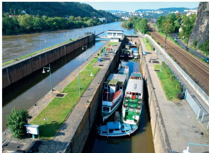
Plavební komora VD Střekov posloužila během povodně jako ochranný přístav 20. 9. 2024
