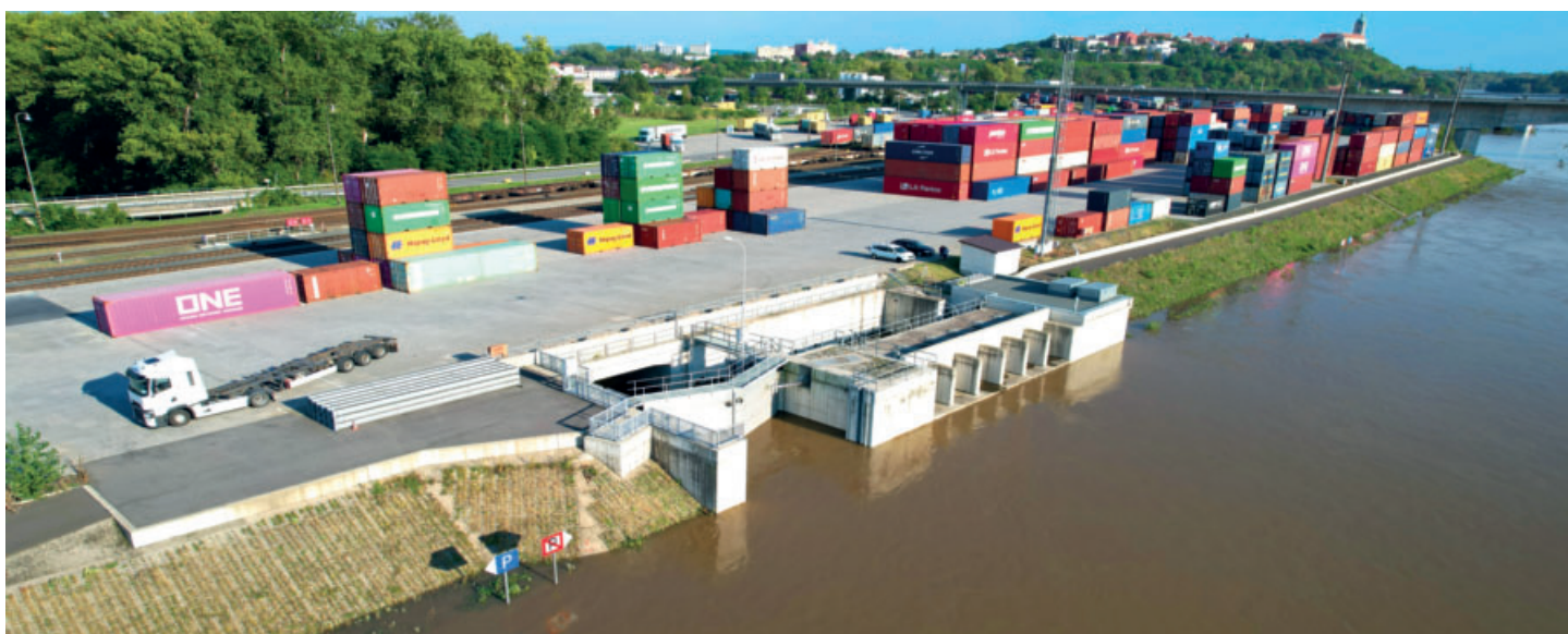
Protipovodňová vrata a čerpací stanice říčky Pšovka v přístavu Mělník během nejvyšší hladiny Labe 18. 9. 2024
