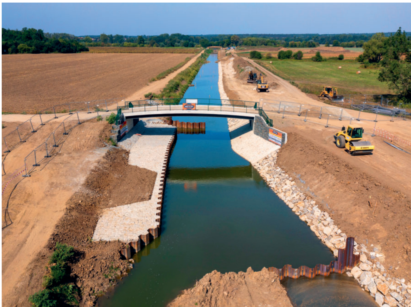
Práce na rozšiřování koryta řeky Radějovky probíhají od jara
