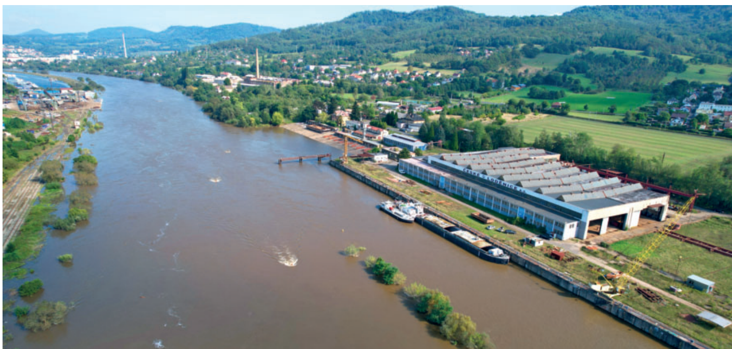
Labe u areálu Českých loděnic v Děčíně-Křešicích 19. 9. 2024
