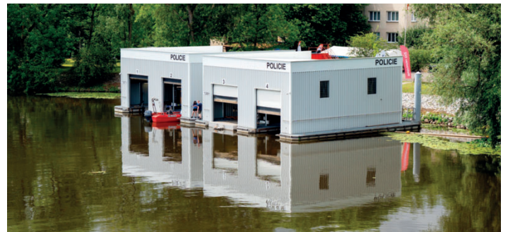
Nové plovoucí garáže pro služební plavidla poříčního oddělení Nymburk
