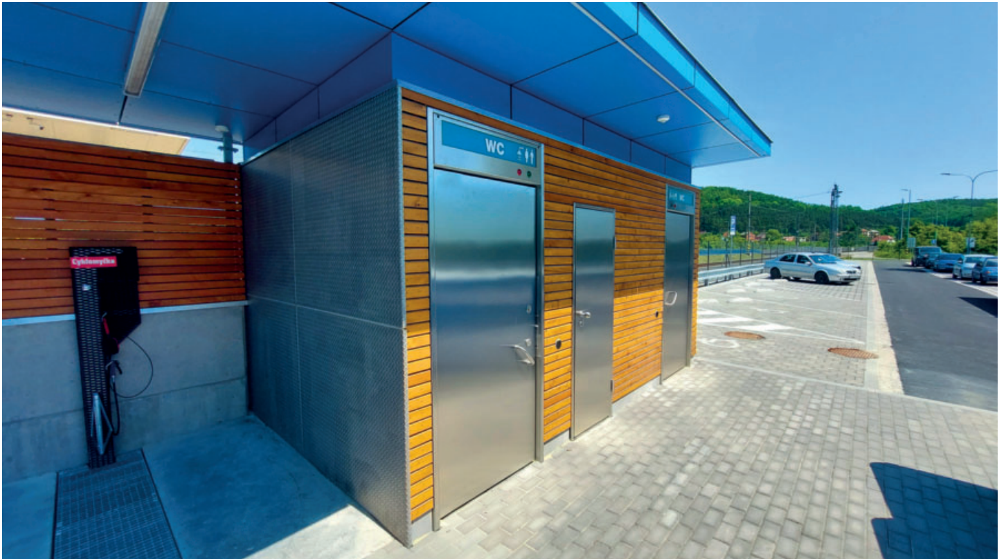
Kuřim – Součástí nádraží je i modulární toaleta DAKO, která slouží nejen cyklistům, ale i cestujícím. Cyklopoint je nedílnou součástí tohoto modulu
