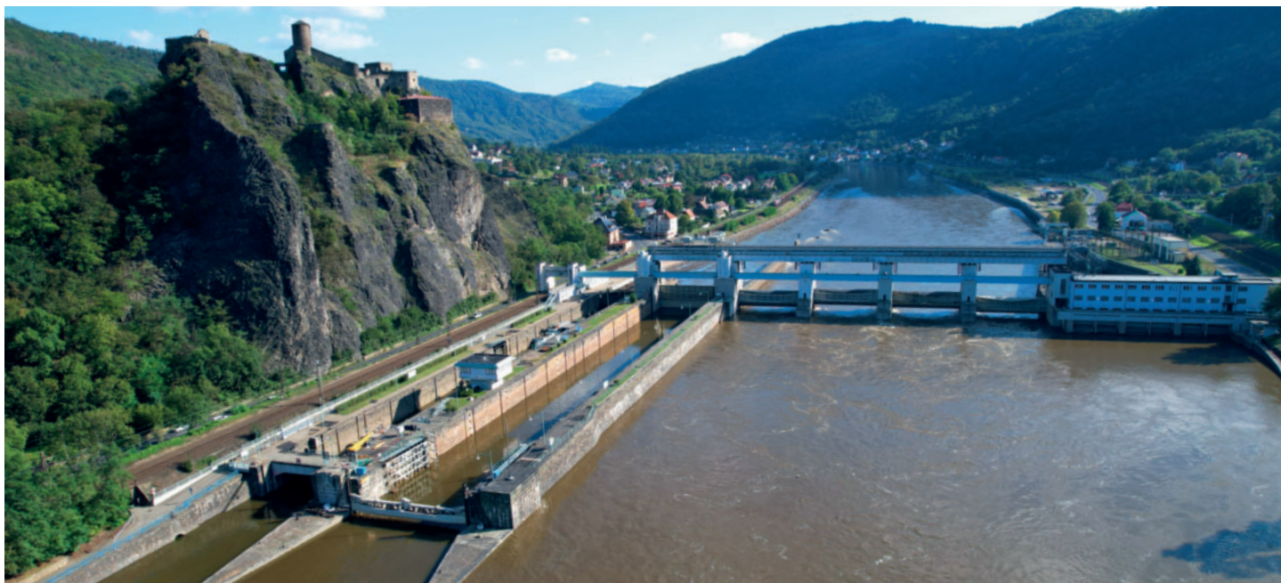
Vodní dílo Střekov se zdviženými tabulovými uzávěry, kterými volně prochází velká voda 20. 9. 2024
